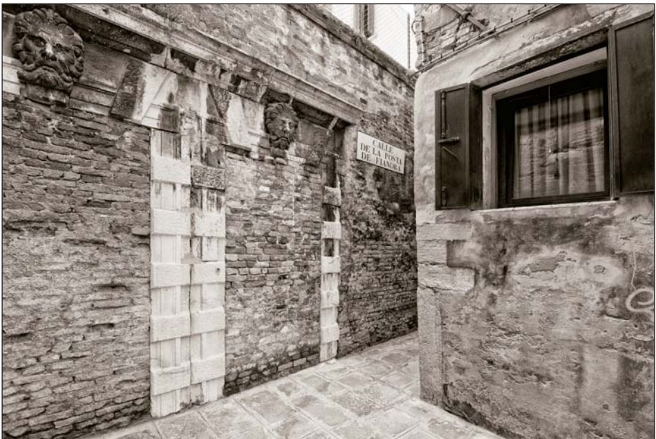
Calle della Posta di Fiandra delimitata da un muro in cui sono inserite due porte cieche, forse le uniche vestigia del palazzo Morosini-Tassis demolito nel 1820 (foto Stefano Bombardieri)
