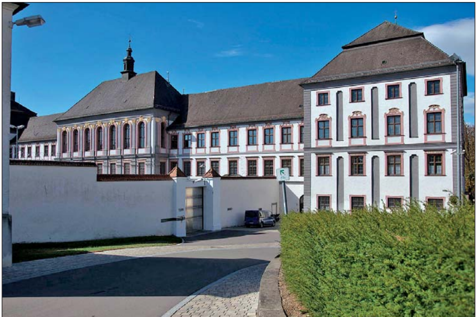
Il Penitenziario di Kaisheim (D) oggi
