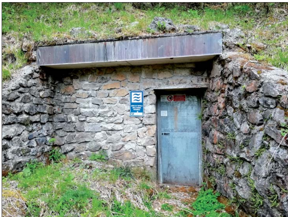
Presa ristrutturata della sorgente Gaiazzo del 1909
