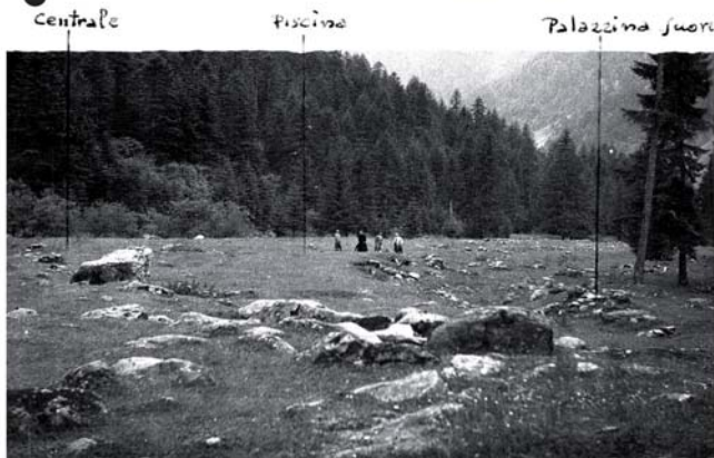
Vista dall'edificio principale
