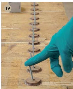
Il sistema di controllo elastico delle traverse
