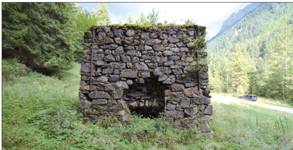
Reglana di Plagna, Schilpario (BG), edificata agli inizi del XX secolo (GRASSI 2021), foto E. Croce 2025
